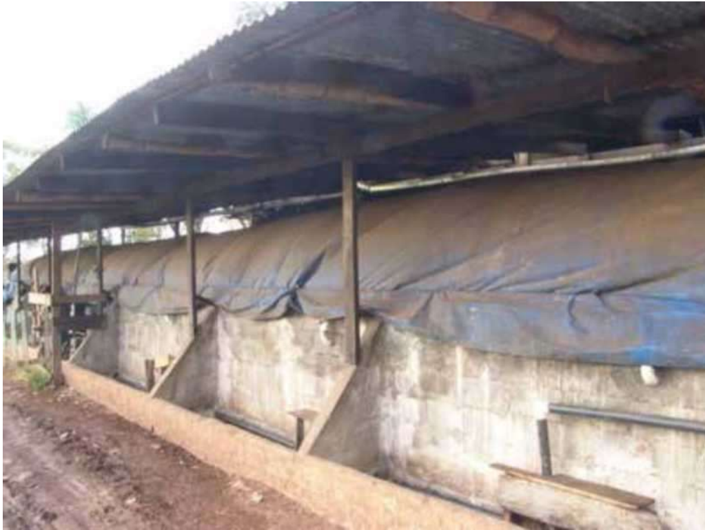
Figura 15. Biodigestor para la generación de gas metano en ranchos ganaderos. Esta tecnología contribuye a disminuir los costos de compra de gas y de uso de leña (Esparza, Costa Rica, foto tomada por Jiménez-Trujillo, JA. 2007).
